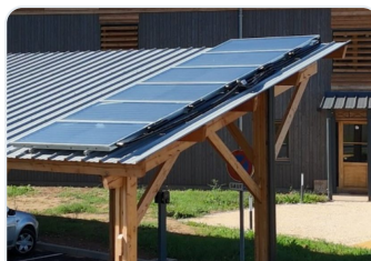
L'ombrière du CERF
