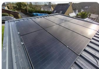
Pose sur bac acier
